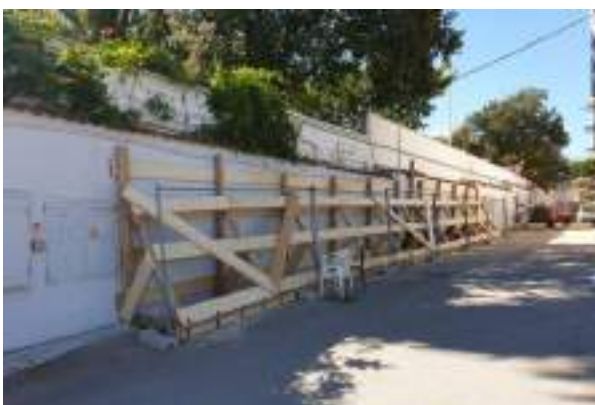
Lavori di messa in sicurezza del muro di confine
