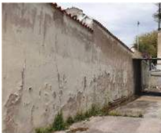
La situazione del Muro prima degli interventi
